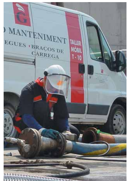
Mantenimiento y reparación. Repairs and maintenance.
